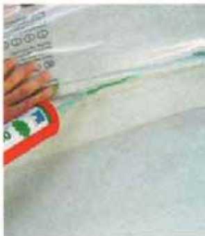
Raccord du freine-vapeur à une dalle en console avec pro clima ORCON F.
