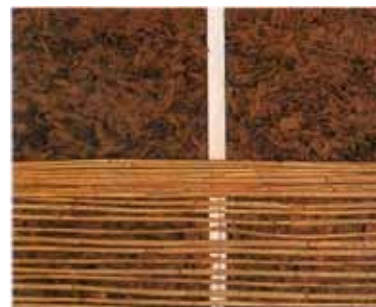
Mortier de terre-copeaux de bois et coffrage perdu en treillis de roseaux (doc. Claytec).
