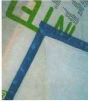
Raccord du freine-vapeur à une cheminée en éléments de montage lisse, non poreuse et non friable avec pro clima TESCON PROFIL.
