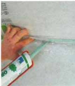
Raccord du freine-vapeur à une cheminée enduite avec pro clima ORCON F.
